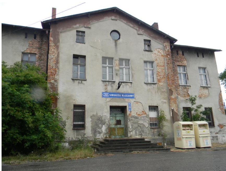
Rysunek 29. Budynek nieczynnego dworca PKP.
