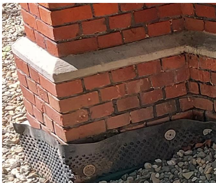
Fragment izolacji pionowej wraz pasem betonowy na cokole ściany.
