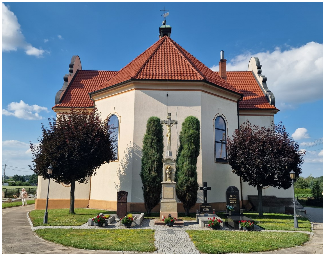
Foto. 4 Widok elewacji tylnej
