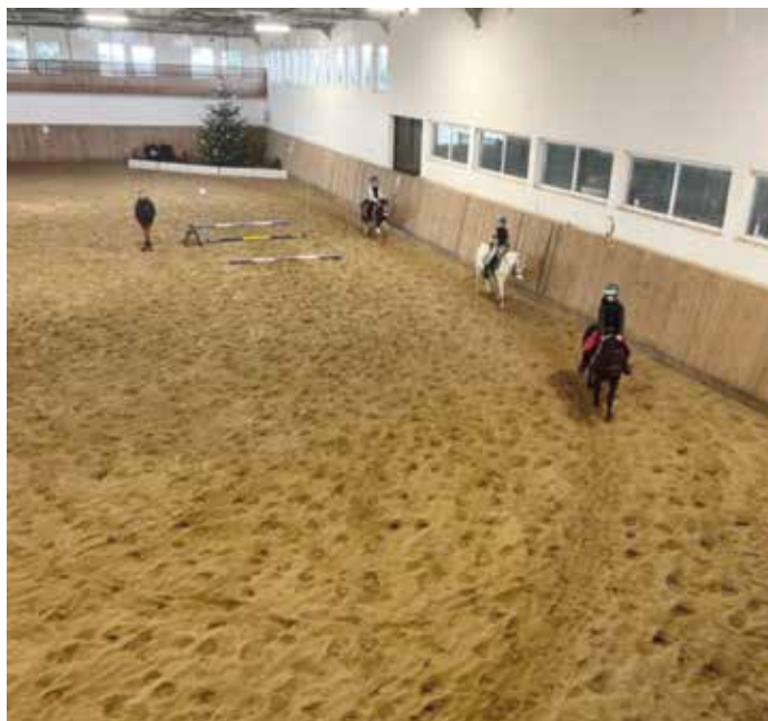
Murowana, ciepła hala, na której odbywają się jazdy w razie niepogody
