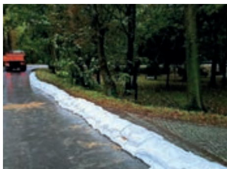
Worki z piaskiem jako zabezpieczenie wokół kościółka św. Krzyża
